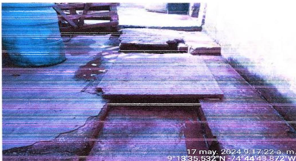
Figura N° 3. Registros que conectar con el sistema de alcantarillado.
